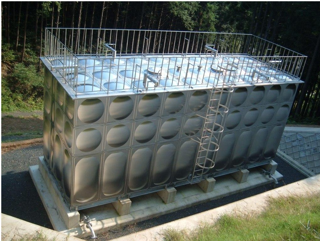
地頭簡易水道大俣第 1 配水池
