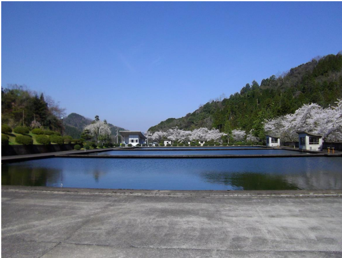
与保呂浄水場緩速ろ過池
